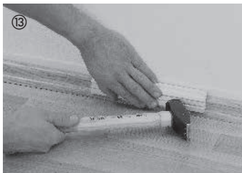
13 Dopo la posa togliere assolutamente i cunei distanziali. Fissare alla parete i battiscopa (montabili con o senza il sistema Clip). Fatto!
