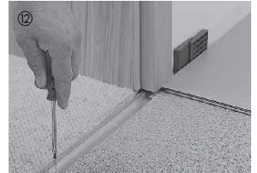
12 Per rispettare la distanza di dilatazione, inserire sempre un sistema di profili adeguato nei passaggi delle porte. Questo vale anche se nell'area adiacente deve essere posato lo stesso pavimento. In questo caso, per mantenere il giunto di dilatazione occorre impiegare un profilo di giunzione. Nella guida mantenere una distanza di dilatazione di circa 5 mm. In linea di massima, si devono tagliare con una sega fine i piani delle porte in legno nello spessore degli elementi, per far sì che il parquet abbia la possibilità di dilatarsi.
