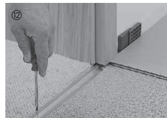
12 Pour maintenir le jeu de dilatation aux seuils des portes, utiliser toujours un système de profil adapté. Procéder de la même manière pour la pose « continue » dans une pièce contiguë. Dans ce cas, un joint de dilatation est nécessaire, il sera masqué avec un profil de même-niveau. Un jeu de dilatation d'environ 5 mm sera respecté dans le profil. Le bas du montant de la porte doit être coupé avec une scie fine à hauteur de l'épaisseur de l'élément pour que le parquet puisse se dilater sous le montant.
