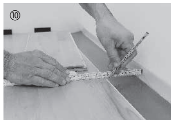
10 Couper les grands côtés des éléments de la dernière rangée en tenant compte du jeu de dilatation de 10 à 15 mm et les emboîter.
