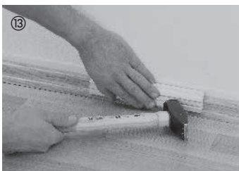
Nach der Verlegung unbedingt die Abstandswelle entfernen. Sockelleisten (mit und ohne Clip-System montierbar) werden an der Wand befestigt – fertig.
