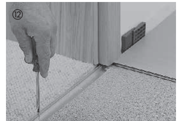
Zur Einhaltung des Dehnungsabstandes muss bei Türübergängen stets ein geeignetes Profilsystem eingesetzt werden. Dies gilt auch, wenn im angrenzenden Raum der gleiche Boden verlegt werden soll. In diesem Fall ist für die Einhaltung der Dehnungsfuge ein Übergangsprofil einzusetzen. In der Schiene ist ein Dehnungsabstand von ca. 5 mm einzuhalten. Grundsätzlich müssen Holztürstöcke in Parkettelementdicke mit einer Feinsäge abgeschnitten werden, damit das Parkett eine Dehnungsmöglichkeit hat.
