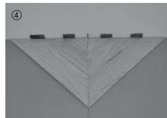
④ Prima di tutto unire tre elementi sinistri e tre destri senza colla formando una sorta di "testa". Disporre questa "testa" allineandola alla corda tracciante. Misurare le distanze dalla parete e tagliare a misura gli elementi. I ritagli possono essere utilizzati sull'altra estremità della treccia. La corda tracciante (centro del disegno di posa) passa esattamente per il centro del locale. Il numero delle file si ricava dividendo la larghezza del locale per la larghezza di copertura (523 mm) di un elemento (vedi fig. 1).
