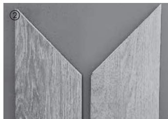
② Listello sinistro: linguetta in alto e punta a sinistra Listello destro: linguetta in alto e punta a destra
