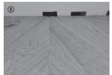
Adapte los elementos restantes en la zona de la pared con un corte de sierra de 45° (calcule una distancia perimetral a la pared de aprox. 10-15 mm).
