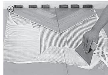
④ Applicare la colla seguendo la corda tracciante disposta in posizione centrale. Adagiare sul letto di colla gli elementi precedentemente posati e unirti tra loro. Applicare la quantità di colla necessaria per incollare il numero di listelli posabili nel giro di 15 minuti (quantità d'uso 800 -- 1000 mg/m<sup>2</sup>).
