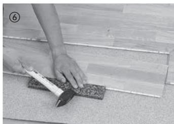
Dopo l'applicazione del collante, unire gli elementi senza giunti con il legno di battuta (inserito prima del lato maschio) e il martello - sfalsamento anteriore di almeno 50 cm.
