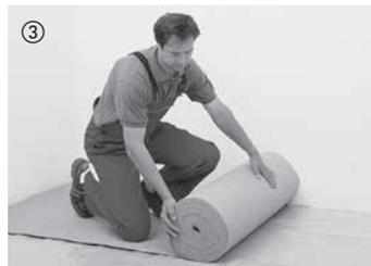
Per isolare rumori da calpestio e per compensare piccole asperità stendere a livello una base isolante in sughero dello spessore di 2 mm. Nella nostra gamma di accessori potete trovare varie tipologie di basi isolanti. Il cartone bitumato e la moquette non sono adatti per isolare rumori da calpestio.
