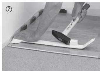
Con la leva di montaggio unire frontalmente l'ultimo elemento della fila all'elemento precedente. Inserire i distanziatori. Procedere allo stesso modo fila per fila. La leva di montaggio può essere utilizzata anche sotto termosifoni.
