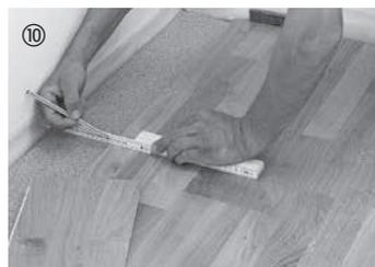
Dessiner, scier, appliquer la colle et assembler avec la barre d'assemblage les éléments de la dernière rangée en respectant le jeu périphérique (10 – 15 mm).
