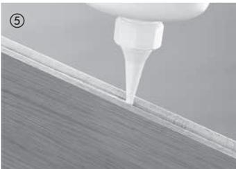
La pose des autres rangées a désormais lieu par l'encollage des rainures et languettes. Appliquer de la colle de manière continue sur la partie supérieure de la rainure.
