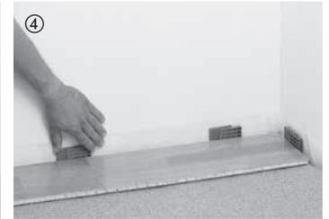
Avec la rainure côté mur, la 1<sup>re</sup> rangée est placée tout droit, collée sur le petit bout de la lame (voir image 5) et fermement fixée avec des cales biseautées – en respectant un jeu périphérique de 10 – 15 mm. La 2<sup>ème</sup> rangée peut être commencée avec le reste de la 1<sup>ère</sup> rangée pour éviter trop de chutes (env. 1 % pour les planches larges à l'anglaise).
