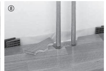
Para los tubos de calefacción salientes del suelo, son taladradas y cortadas aberturas en los elementos (tamaño en función del respectivo tubo de radiador y bajo consideración de la distancia de dilatación requerida).
