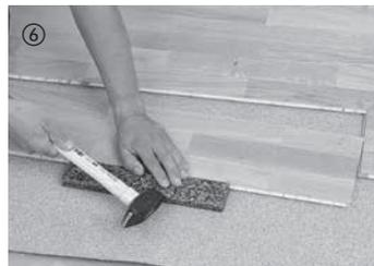
Una vez aplicada la cola, empalmar los elementos sin dejar juntas con un bloque para golpear (colocados delante de la lengüeta) y un martillo; el desplazamiento frontal hacia la hilera anterior deberá ascender a un mínimo de 50 cm.
