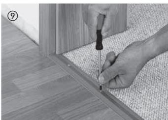
A fin de guardar la distancia hacia los bordes, debe ser instalado un sistema de perfil en transiciones de puerta. Al efectuar una instalación "continua" a un recinto lindante, se requiere una junta de separación. Ésta debe ser dotada de un perfil de transición. En el carril debe guardarse una distancia de dilatación de 5 mm. Básicamente deben ser cortados marcos de puerta de madera al grosor de los elementos empleando una sierra fina, a fin de que el parquet pueda dilatarse.
