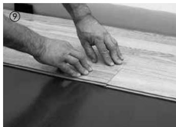
⑨ Derefter lægges elementet med enden først. Vær opmærksom på, at elementet støder helt op mod det tidligere lagte element i enden. Ved et kort tryk på tværsamlingen klikker elementet ind.
