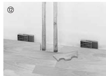
⑫ Til rørgennemføringer bores eller saves passende huller i elementerne. Størrelsen afhænger af det pågældende varmerør, og der skal tages højde for den nødvendige ekspansionsafstand.
