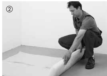
Grundsätzlich ist bei allen Estrichen und bei Verlegung auf Fußbodenheizung eine 0,2 mm starke PE-Folie auszulegen. Diese soll im Stoßbereich 30 cm überlappen. Anschließend die Folie im Wandbereich hochziehen und nach der Sockelleistenmontage an der Oberkante abtrennen.
