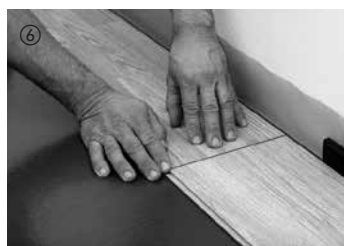
⑥ Gli altri elementi della prima riga vanno incastrati dall'alto con le estremità della tavola nella tavola precedente. Premendo brevemente sul giunto orizzontale, l'elemento scatta in posizione nell'elemento adiacente. Occorre prestare attenzione all'esatto allineamento degli elementi. Tagliare e inserire l'ultimo elemento della prima fila, considerando una distanza di dilatazione di 10 - 15 mm verso la parete.
