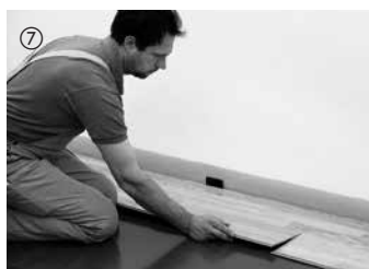
⑦ Ricominciare con la fila successiva utilizzando il pezzo rimanente della prima fila (elementi sfalsati di almeno 50 cm). In questo modo si riducono notevolmente gli scarti. Proseguire con la posa elemento per elemento. A questo scopo, con una lieve pressione, ruotare prima longitudinalmente gli elementi nel collegamento.
