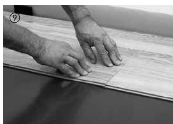
⑨ Successivamente l'elemento viene abbassato sul lato corto. Accertarsi che l'elemento si accosti con il lato anteriore a livello con l'elemento posato in precedenza. Premendo brevemente sul giunto orizzontale, l'elemento scatta in posizione.
