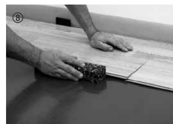
⑧ In caso di necessità, battere leggermente con l'apposito legno.
