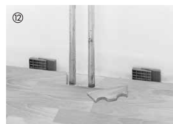
⑫ Per i tubi del riscaldamento che spuntano dal pavimento, eseguire delle aperture negli elementi con il trapano o la sega (dimensioni in relazione al tubo di riscaldamento in questione e tenendo conto della distanza di dilatazione necessaria).
