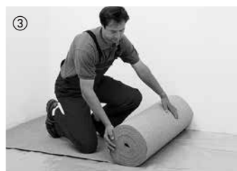
③ Per isolare rumori da calpestio e per compensare piccole asperità stendere a livello una base isolante in sughero dello spessore di 2 mm. Nella nostra gamma di accessori potete trovare varie tipologie di basi isolanti. Il cartone bitumato non è adatto per isolare rumori da calpestio. Con pavimento in laminato HARO con Silent Pro ® non si possono posare basi isolanti supplementari.
