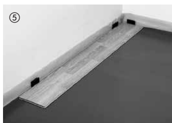
⑤ Partendo dall'angolo destro del locale, posare gli elementi con il lato maschio rivolto verso la parete e fissarli con cunei distanziali (distanza di dilatazione di 10-15 mm verso la parete).
