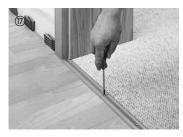
Nella guida mantenere una distanza di dilatazione di circa 5 mm. In linea di massima, gli infissi delle porte in legno vanno tagliati con una sega fine nello spessore degli elementi, per far sì che il pavimento in laminato abbia la possibilità di dilatarsi.
