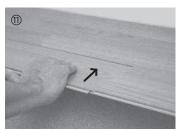
Successivamente, fissare l'elemento esercitando una leggera pressione con i palmi delle mani anche nell'area destra. Compiere questa operazione prestando attenzione a non abbassare l'elemento sul lato lungo.
