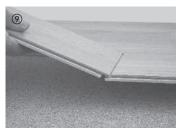
L'elemento successivo di questa fila si inserisce sul lato corto nell'elemento già posato.
