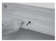
Fixer ensuite l'élément également sur le côté gauche grâce à une légère pression des paumes. Veillez à ce que l'élément posé dans le sens de la longueur ne soit pas incliné.
