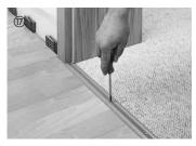
Un jeu de dilatation d'environ 5 mm sera respecté dans le profil. Le bas du montant de la porte doit être coupé avec une scie fine à hauteur de l'épaisseur de l'élément pour que le revêtement de sol stratifié puisse se dilater sous le montant.
