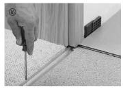
Pour maintenir le jeu de dilatation aux seuils des portes, un profil d'adaptation sera vissé sur le support. Procéder de la même manière pour la pose " continue " dans une pièce contiguë. Dans ce cas, un joint de dilatation est nécessaire, il sera masqué avec un profil de mêmeniveau.
