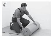
Pour l'isolation phonique et l'égalisation des petites aspérités, il convient de dérouler jusqu'aux bords un rouleau de liège de 2 mm d'épaisseur. D'autres sous-couches isolantes alternatives sont également disponibles parmi notre gamme d'accessoires. Le carton bitumé ne se prête pas à l'isolation phonique. Pour les sols stratifiés HARO Silent Pro®, ne pas poser de sous-couche isolante supplémentaire.
