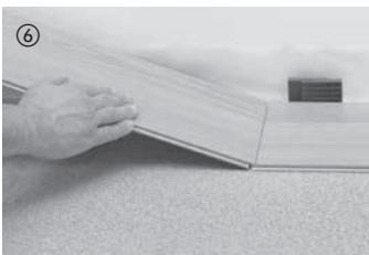
Coloque los elementos de la primera fila. Para ello, primero se introducen las planchas del lado frontal ejerciendo una ligera presión en la unión.
