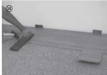
Ahora se puede ensamblar el elemento horizontalmente empleando un martillo y un taco para golpear. Para facilitar la instalación de los elementos de la parte frontal, se recomienda el empleo de una hendidura de solapamiento de los elementos en los bordes longitudinales.
