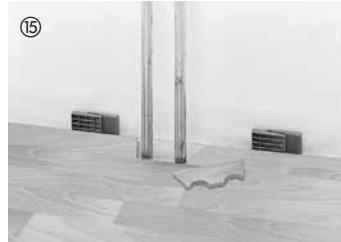
Para los tubos de calefacción salientes del suelo, son taladradas o cortadas aberturas en los elementos (tamaño en función del respectivo tubo de radiador y bajo consideración de la distancia de dilatación requerida).
