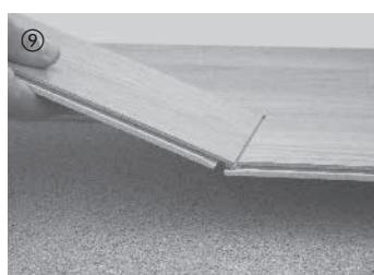
El siguiente elemento de la lista se introduce frontalmente en el elemento ya colocado.
