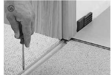
A fin de guardar la distancia hacia los bordes, debe ser instalado un sistema de perfil en transiciones de puerta. Al efectuar una instalación „continua“, a un recinto lindante, se requiere una juntura de separación. Ésta debe ser dotado de un perfil de transición.
