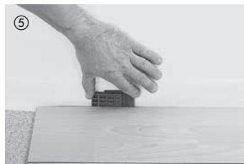
Comenzando por la esquina derecha de la habitación, los elementos con el lado de la lengüeta se colocan hacia la pared y se fijan con cuñas distanciadoras (distancia de dilatación con respecto a la pared de 10--15 mm).
