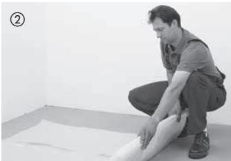
Es necesario extender una lámina de PE de 0,2 mm de grosor en todos los soldados y al efectuarse la instalación sobre calefacción de suelo radiante, debiendo solaparse 30 cm en la zona de unión. A continuación, levantar la membrana por la pared y, tras la instalación de los zócalos, cortarla a ras con el borde superior de éstos.
