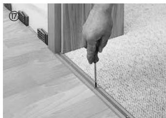
El carril debe ser guardada una distancia de dilatación de 5 mm. Básicamente deben ser cortados marcos de puerta de madera al grosor de los elementos empleando una sierra fina, a fin de que el suelo laminado pueda dilatarse.
