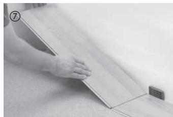
El último elemento de la primera fila se corta considerando la distancia de dilatación de 10-15 mm con respecto a la pared, y se introduce de forma inclinada. Con la pieza sobrante de la primera fila se vuelve a empezar en la siguiente fila (desplazamiento frontal de al menos 40 cm). Gracias a esto se reducen considerablemente los desperdicios.
