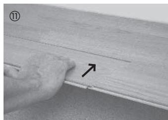
Anschließend ist das Element mit leichtem Druck durch den Handballen auch im rechten Bereich zu fixieren. Bitte beachten, dass dabei das Element längsseitig nicht abzusenken ist.
