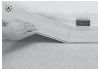
Verlegen Sie die Elemente der ersten Reihe. Dazu werden die Dielen zuerst stirnseitig mit leichtem Druck in die Verbindung eingedreht.
