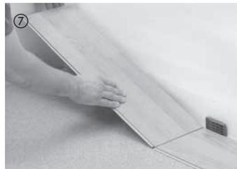
Das letzte Element der ersten Reihe wird unter Berücksichtigung des Dehnungsabstandes von 10--15 mm zur Wand zugeschnitten und schräg eingedreht. Mit dem Reststück der ersten Reihe wird in der nächsten Reihe wieder begonnen (stirnseitiger Versatz von mindestens 40 cm). Dadurch wird der Verschnitt erheblich reduziert.
