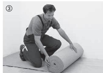
Zur Trittschalldämmung und zum Ausgleich kleiner Unebenheiten wird eine 2 mm dicke Korkdämmunterlage bündig ausgerollt. Alternative Dämmunterlagen finden Sie in unserem Zubehörangebot. Bitumpappe eignet sich nicht zur Trittschalldämmung. **Bei HARO Laminatboden mit Silent Pro® darf keine zusätzliche Dämmunterlage ausgelegt werden.**
