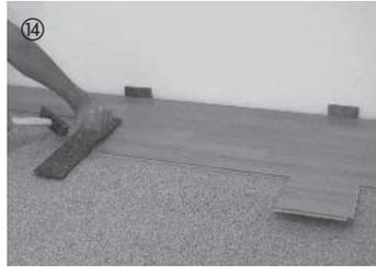
Nun kann das Element mit Hammer und Schlagklotz waagrecht eingeklickt werden. Zur leichteren Verlegung der Elemente im Stirnbereich empfiehlt sich die Verwendung eines elementübergreifenden Anschnitts im Längskantenbereich.
