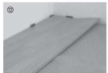
Erst wenn die gesamte Reihe stirn- und längsseitig verbunden ist, kann sie von links nach rechts abgesenkt werden.
