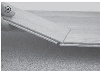
Das folgende Element dieser Reihe wird stirnseitig in das bereits verlegte Element eingeführt.
