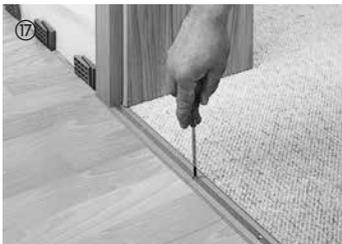
In der Schiene ist ein Dehnungsabstand von ca. 5 mm einzuhalten. Grundsätzlich müssen Holzürstöcke in Bodenelementdicke mit einer Feinsäge abgeschnitten werden, damit der Laminatboden eine Dehnungsmöglichkeit hat.
