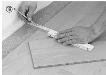
Die Elemente der letzten Reihe werden an der Längsseite unter Berücksichtigung eines Dehnungsabstandes von 10–15 mm zugeschnitten und eingepasst. Nach der Verlegung unbedingt die Abstandskeile entfernen. Sockelleisten (mit und ohne Clip-System montierbar) werden an der Wand befestigt -- fertig.
