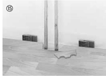
Für aus dem Boden herausragende Heizungsrohre werden in die Elemente Öffnungen (Größe abhängig vom jeweiligen Heizungsrohr und unter Berücksichtigung des erforderlichen Dehnungsabstands) gebohrt oder gesägt.
