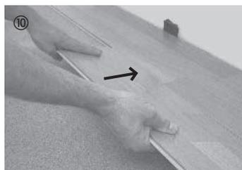
Die Diele ist mit leichtem Druck im linken Bereich in die Verbindung einzudrehen.
