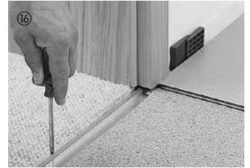
Zur Einhaltung des Dehnungsabstandes muss bei Türübergängen stets ein geeignetes Profilsystem eingesetzt werden. Dies gilt auch, wenn im angrenzenden Raum der gleiche Boden verlegt werden soll. In diesem Fall ist für die Einhaltung der Dehnungsfuge ein Übergangsprofil einzusetzen.
