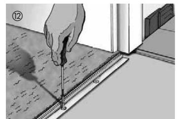
⑫ Pour maintenir le jeu de dilatation aux seuils des portes, utiliser toujours un système de profil adapté. Procéder de la même manière pour la pose « continue » dans une pièce contiguë. Dans ce cas, un joint de dilatation est nécessaire, il sera masqué avec un profil de même-niveau.
